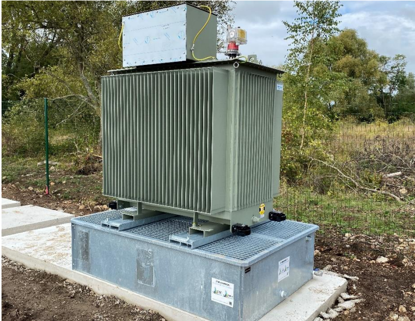
Le 16/09/2021 Pose du transformateur 1250 kVA sur son bac de rétention
