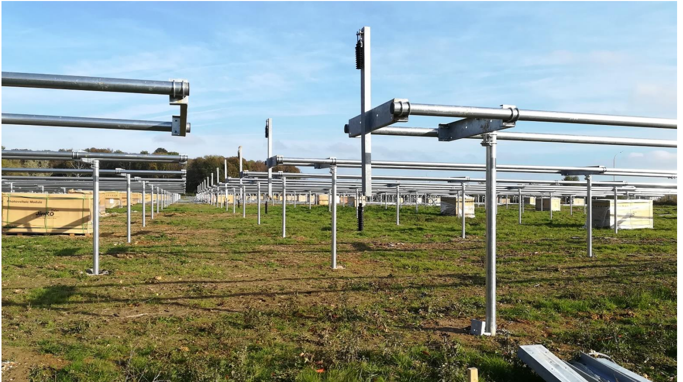
La zone A1 montage structure des zones A1 et A2 le 27/10/2021
