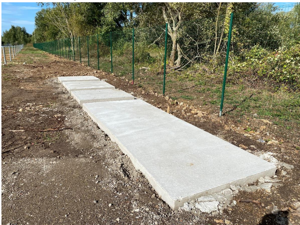
Confection du dallage d'accueil du transformateur 1250 kVA et du TGBT
